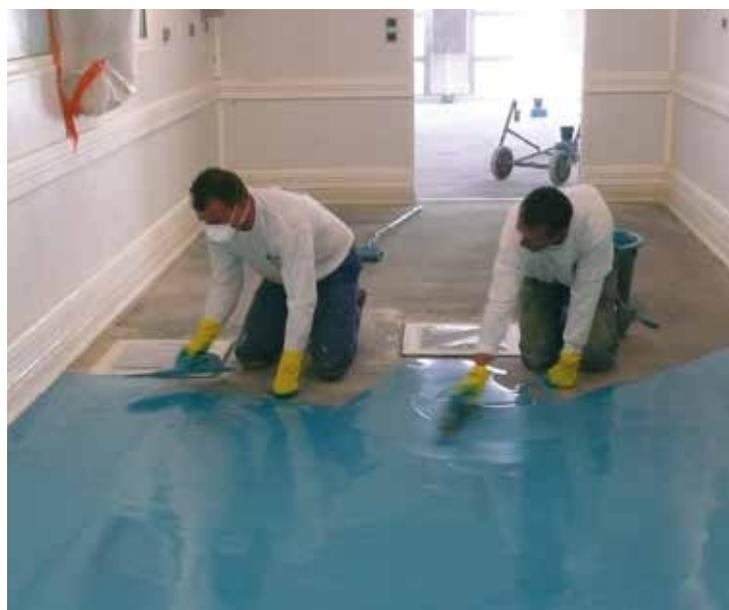
L'étape suivante a été la mise en oeuvre du revêtement autolissant coloré à haute performance à base de polyuréthane ciment : **Sikafloor®-21 N PurCem**.
