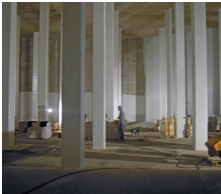
Application du primaire époxydique
